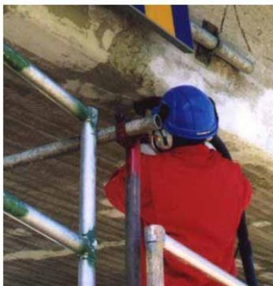
Рисунок 1: Шлифовка шпаклевки для ремонта повреждения.
