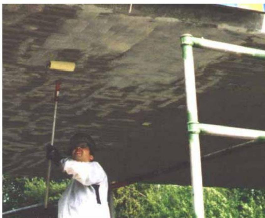
Рисунок 2: Нанесение грунтовки на чистую и гладкую бетонную поверхность.
