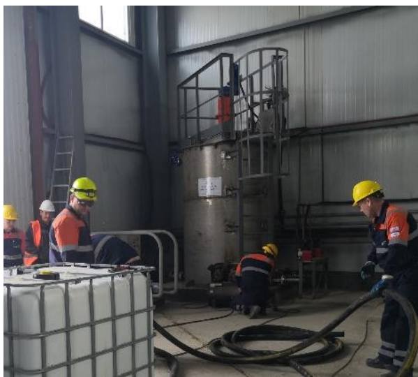
Рис.11 Инокуляция. Расширение насосной станции рафината для размещения питательного (ТК-100) и семенного (ТК-300) баков с насосами, а также склада хранения питательных веществ.
