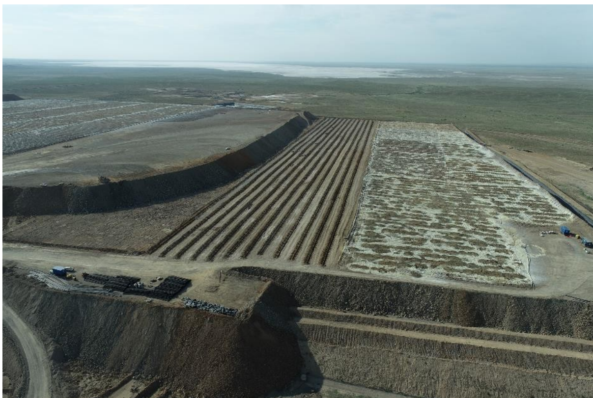
Рис.8 ПКВ-2. Укладка стрингерных труб системы принудительной аэрации
