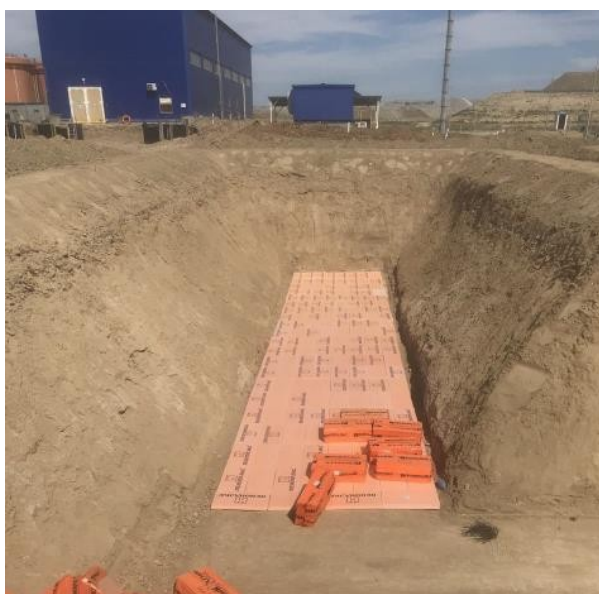
Рис.12 Инокуляция. Строительство пруда инокулята с использованием теплоизоляционного материала Пеноплекс и геомембраны.
