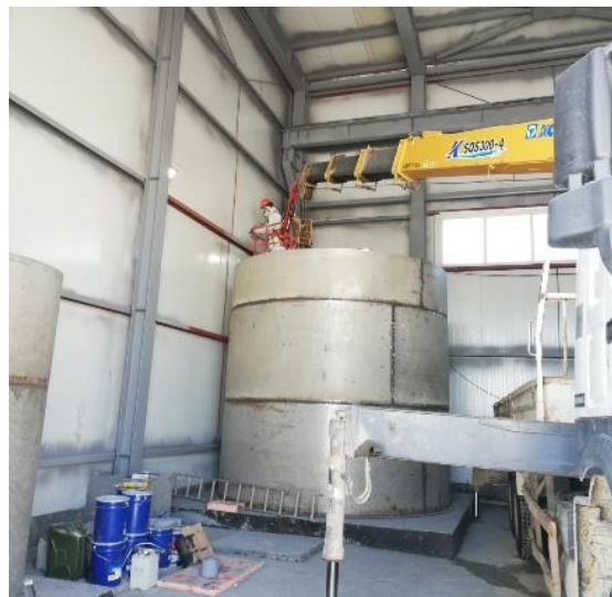
Рис.11 Инокуляция. Расширение насосной станции рафината для размещения питательного (ТК-100) и семенного (ТК-300) баков с насосами, а также склада хранения питательных веществ.
