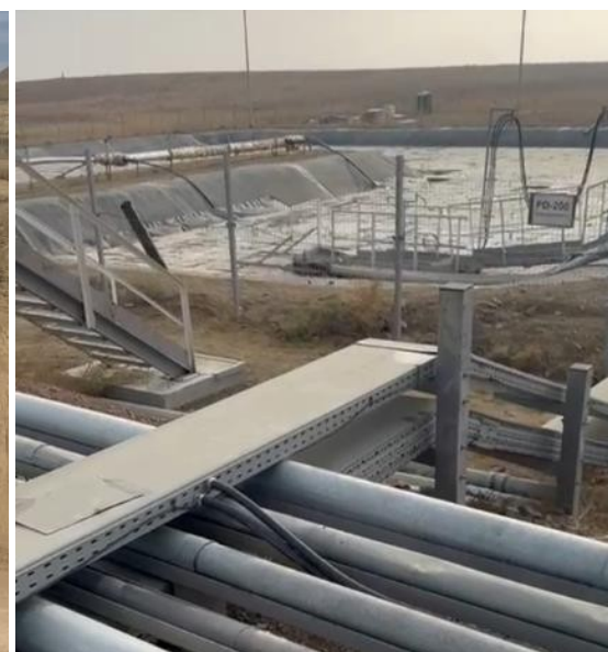
Рис.12 Инокуляция. Строительство пруда инокулята с использованием теплоизоляционного материала Пеноплекс и геомембраны.
