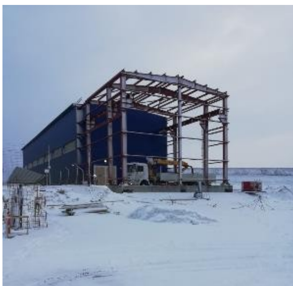
Рис.10 Инокуляция. Расширение насосной станции рафината для размещения питательного и семенного баков с насосами, а также склада хранения питательных веществ.
